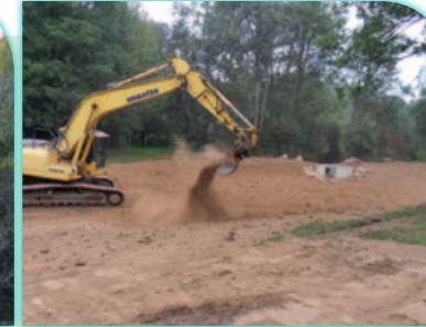
Travaux de terrassement de la frayère à brochets
