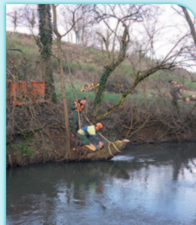
Travaux de restauration de la végétation (Trézenne)
