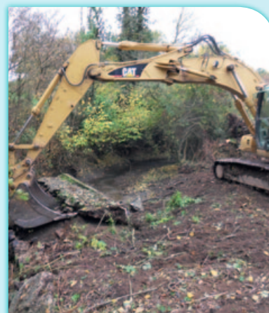
Suppression d'un ouvrage (Trézenne)
