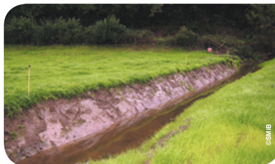
Cours d'eau dégradé
