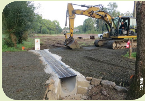
Ouvrage de franchissement
