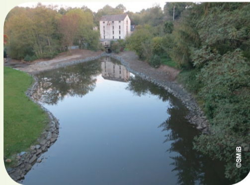
Aménagement de banquettes
