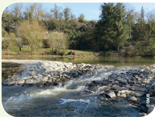
Aménagement d'une passe rustique
