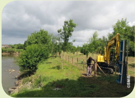
Pose d'une clôture
