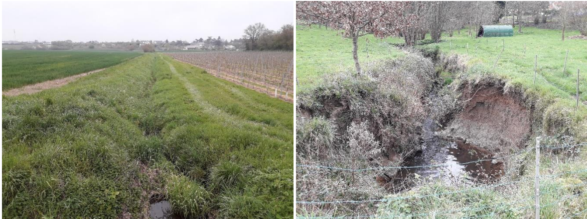
Figure 147 : Situations dégradées - Source : HARDY ENVIRONNEMENT
