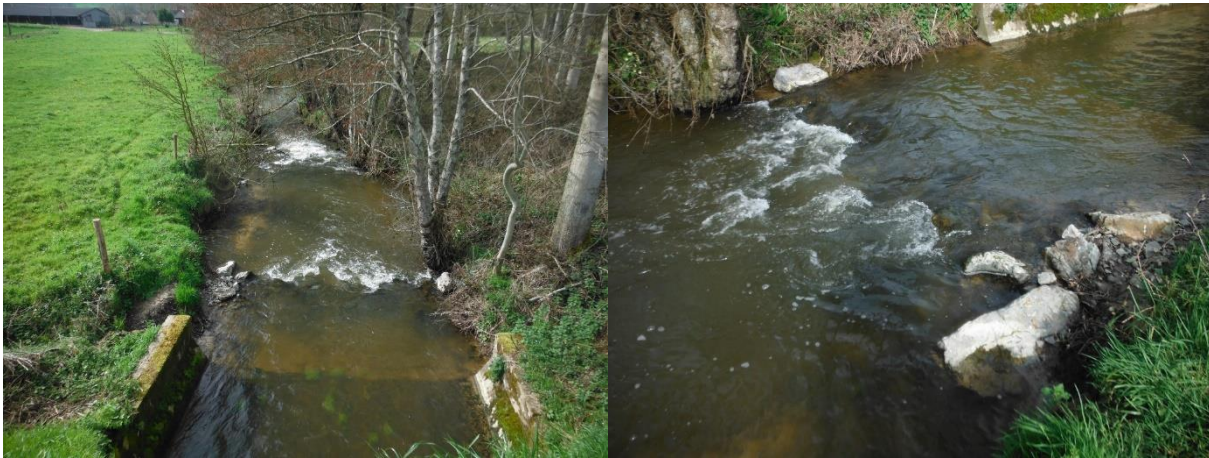
Aménagement de mico-seuils successifs – Source : Hardy Environnement
