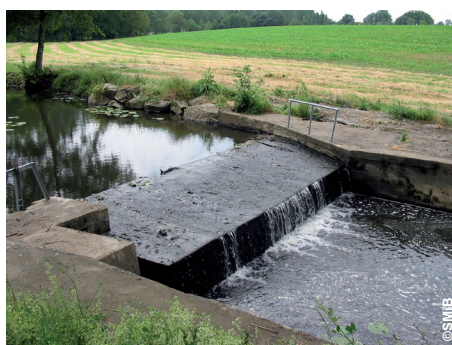
Seuil en béton (Èvre)
