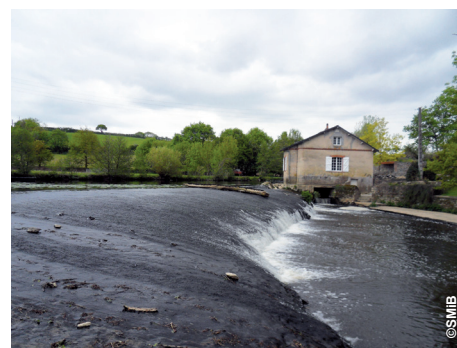
Chaussée de moulin (Èvre)
