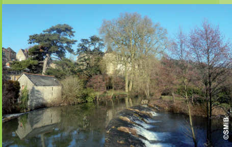
Chaussée de moulin (Èvre)
