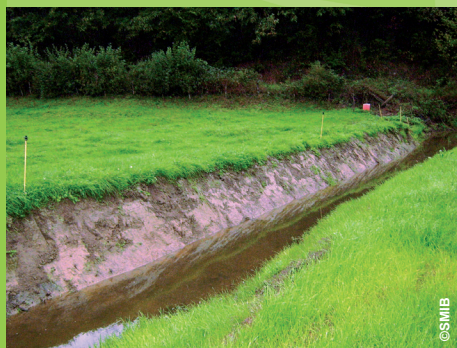
Cours d'eau recalibré (interdit)
